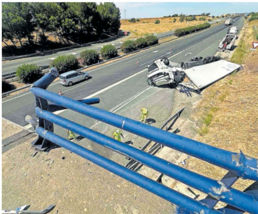
Salida de vía de un camión en un paso elevado de la A-4, en Carmona (Sevilla), el 22 de junio. D. ARJONA (EFE)
