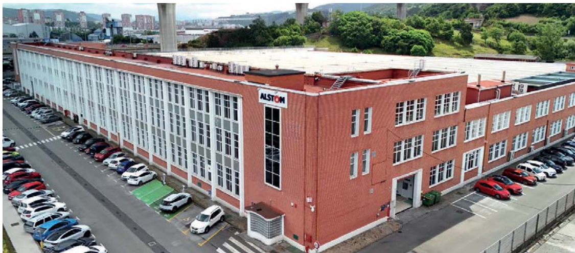
Centro industrial de Alstom en Trápaga, Bizkaia.
