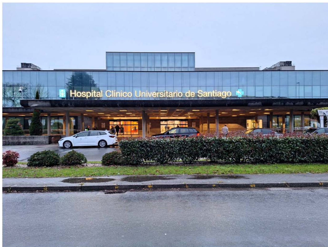
Fachada Hospital Clínico Universitario - Foto DS
